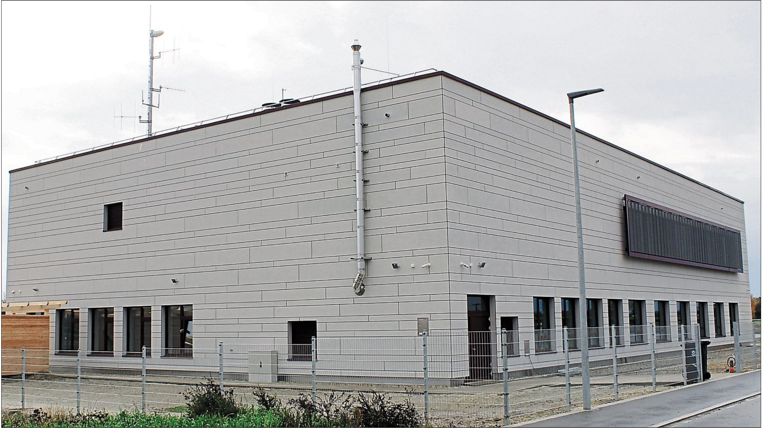
Knapp zwei Jahre nach Baubeginn ist die Integrierte Leitstelle Landshut in Essenbach in Betrieb gegangen.
